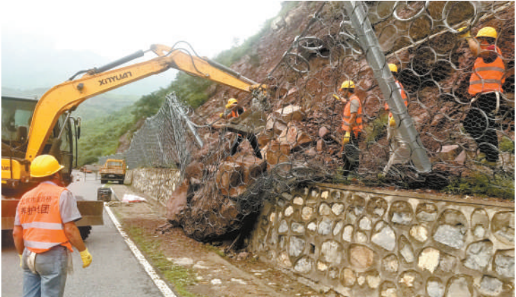
道路养护工人利用山体防护网和挖掘机及时清理了落石。 本报记者 吴锦摄
